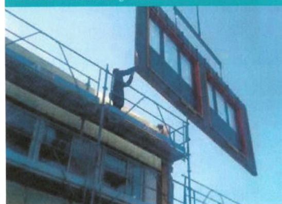
Pose d'un pan de mur préfabriqué pour la réhabilitation du bâtiment 60 à Saint-Chamond. Architecte : Atelier des Vergers.
