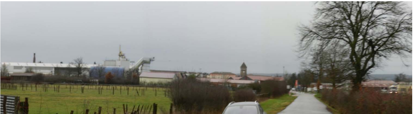
Vues sur la zone la zone d'activités et en arrière-plan le centre-ville de Balbigny depuis le site de l'extension (photo Réalités)
