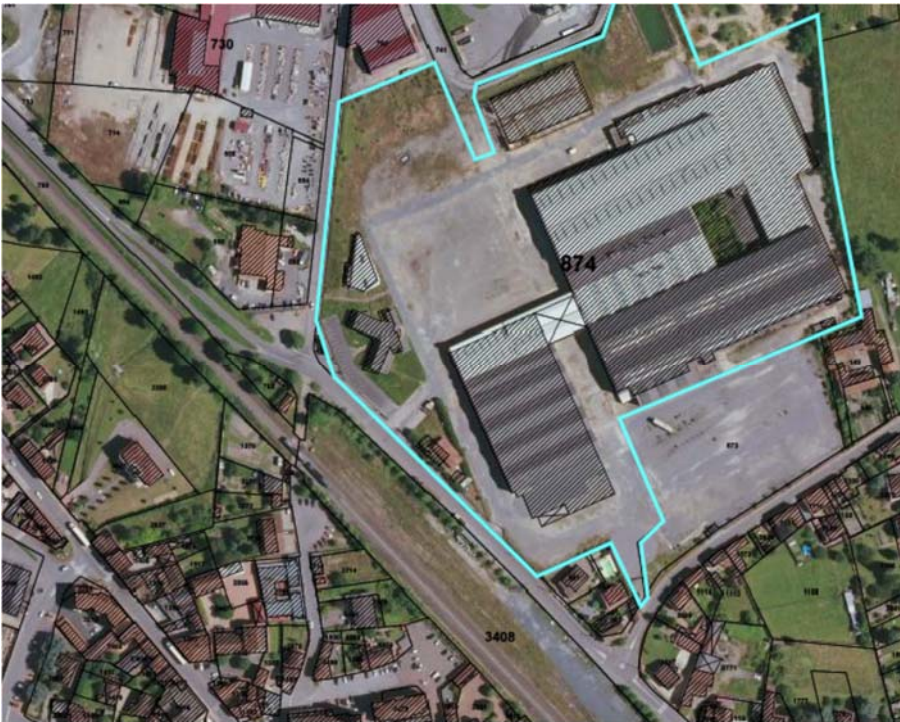
Photo du site Samro avant travaux
