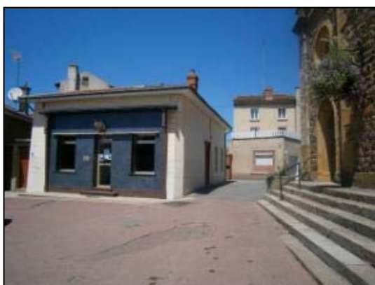
Bâti à l'architecture atypique
