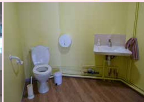
Travaux sanitaires Maternelle
