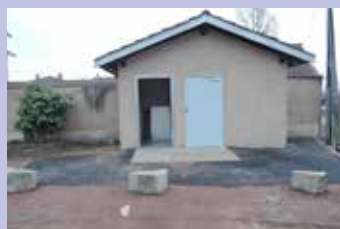
Rénovation des WC publics
