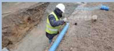
Les travaux de voirie et assainissement • p.6 •
