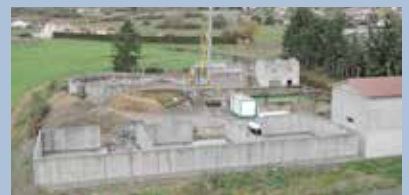
La station d'épuration • p.6 •
