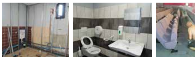
Nouveaux sanitaires Espace Lumière
