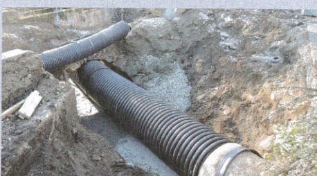
Travaux rue du port
