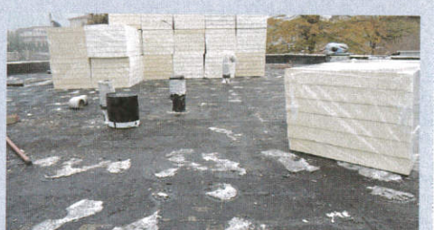
Travaux toit maternelle
