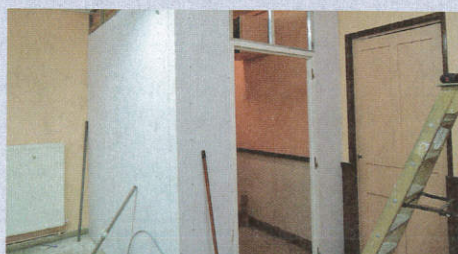
Création toilette amicale laïque
