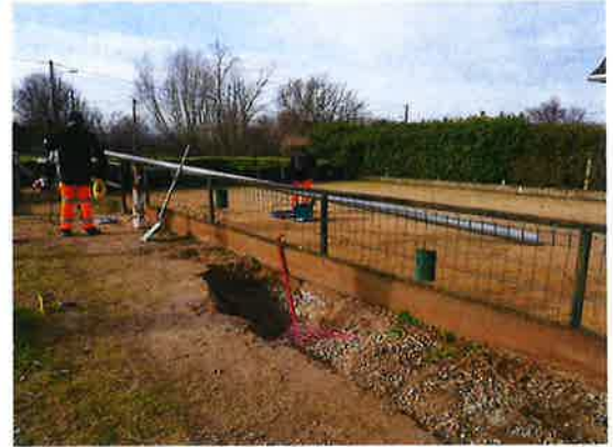
Mise en place d'un nouvel éclairage
